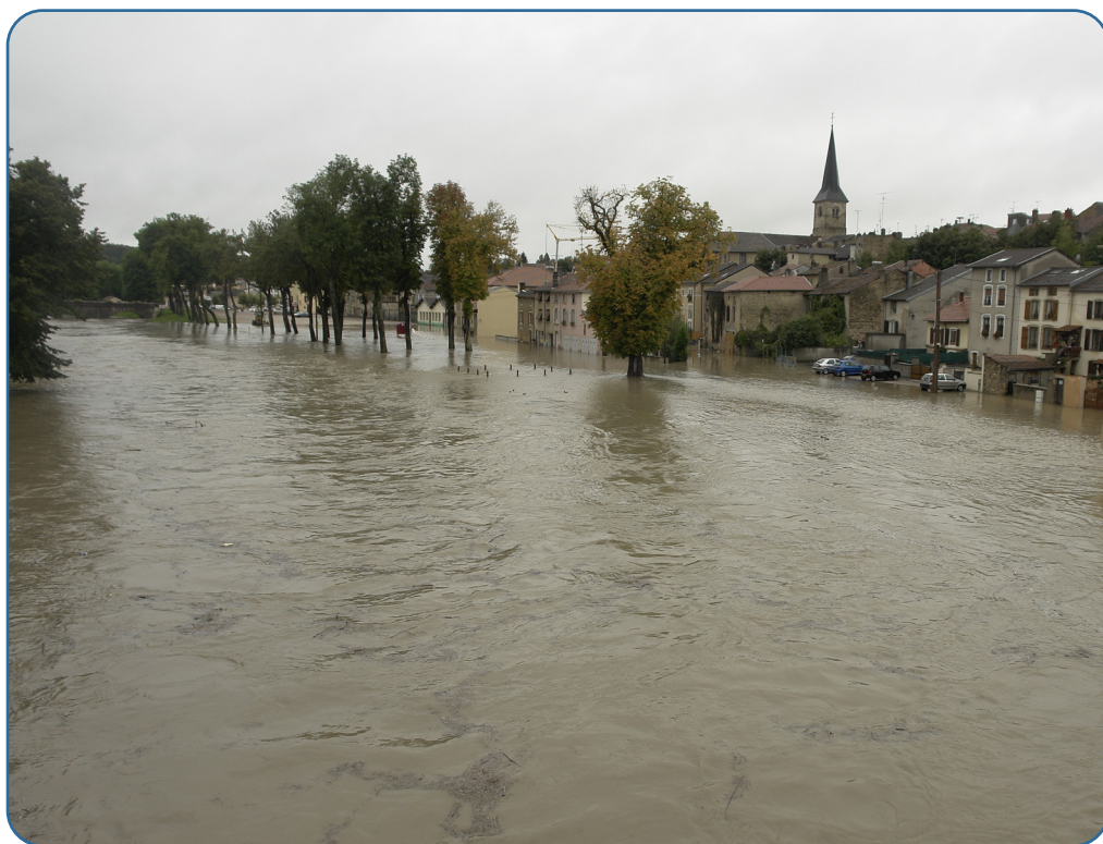
Inondation du 03 octobre 2006 à Mirecourt - © Ville de Mirecourt
